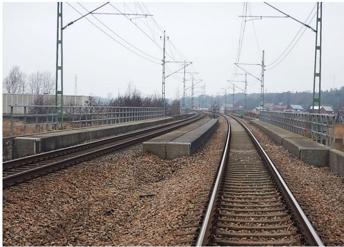
Foto 9: Vy från spåren mot den korta betongbron över ån Viskan
