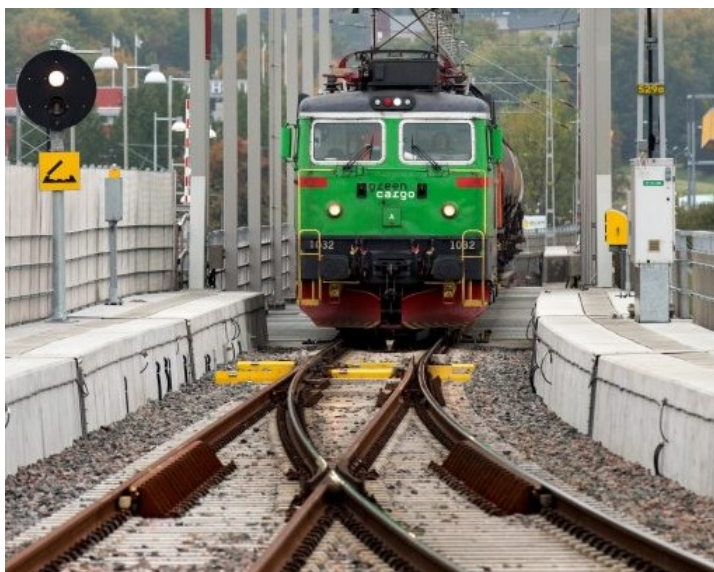
Foto 6: Godståg från Hisingen draget av ett Rd2 lok passerar över den nya stålbron vid Marieholm för vidare färd på anslutande betongbroar i centrala delar av Göteborg
