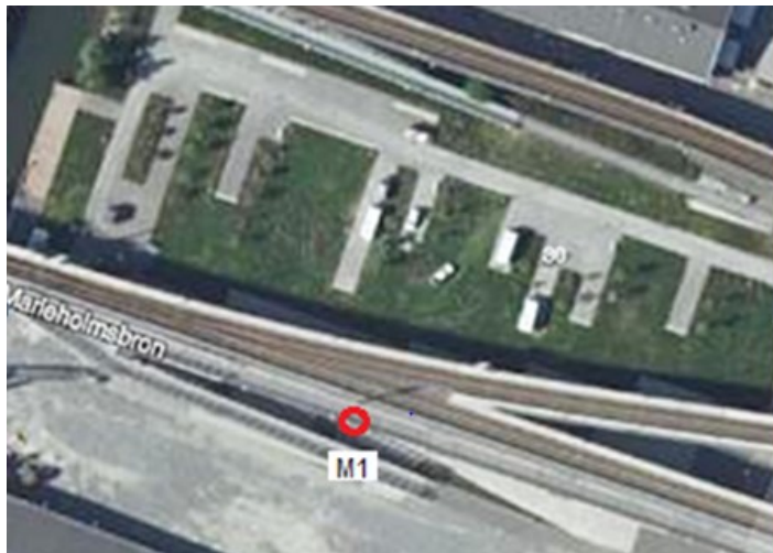
Foto 5: Enkelspår på betongbro vid Marieholm öster om den nya stålbron över Götaälv. Mätpunkten M1 markerad med röd cirkel
