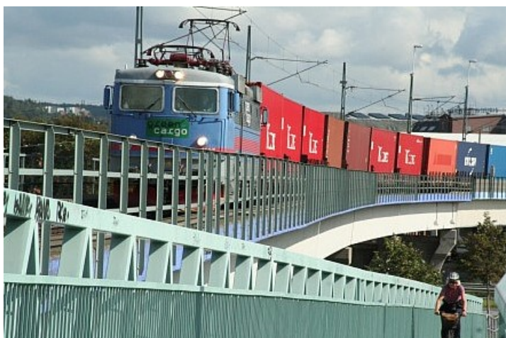
Foto 7: Rc-lok med containers passerar en betongbro vid Marieholm för vidare färd på den gamla stålbron över Götaälv mot Hisingen
